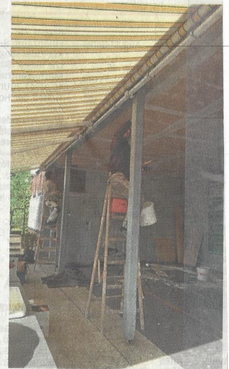
Der TC Foresta Gravenbruch hat unter anderem die Decke saniert. Foto: PM
